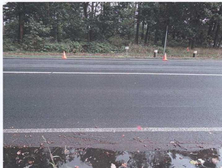
Anlagenbild 12: Messstellenbesichtigung – Einfahrt Parkplatz
